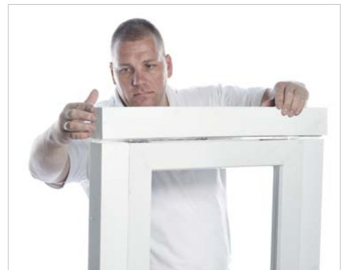
Vorfertigung des Rahmens bei der VAM-Montage („Von Außen Montiert“)
